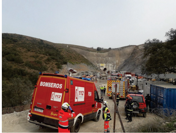
SIMULACRO DE RESCATE POR ACCIDENTE DE TRABAJADORES EN EL TÚNEL DEL HUESNA
